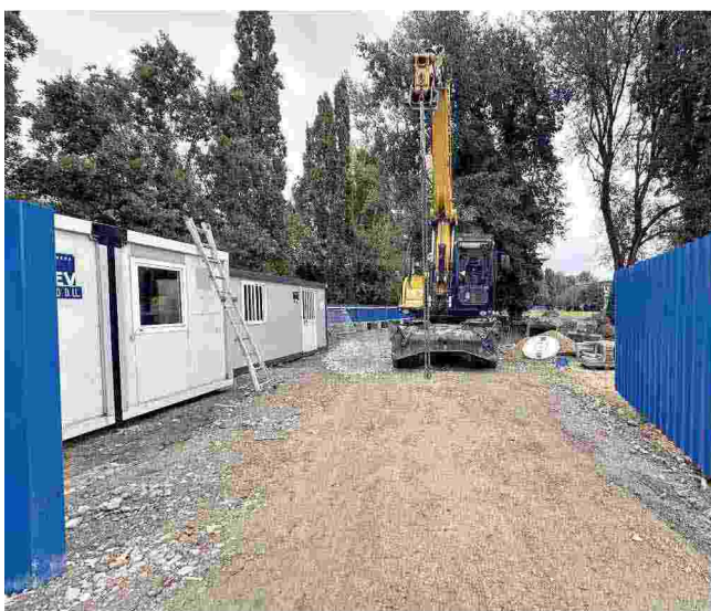
Il cantiere partito nei giorni scorsi in via del Pescarotto
